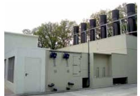
kombiniert mit einer Abluftreinigungsanlage, die den Ammoniakgehalt aus der Luft herausfiltert. Bei der Bindung von Ammoniak mit saurem Waschwasser entsteht Ammoniumsulfat, ein begehrter Flüssigdünger. Die Wärmetauscher werden angeschlossen an den Kreislauf des BHKWs, Ventilatoren saugen die Trockenluft durch Wärmetauscher, Cascata und Abluftreinigung.
