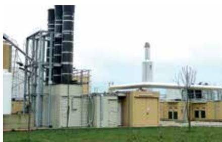
**Containertrocknungsanlagen mit Rückmischung sind verfügbar mit einer Leistung von 200 kWh<sub>th</sub> bis 1MW<sub>th</sub>**
