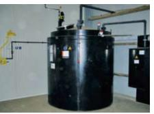
Cuve de stockage d'eaux d'écoulement
