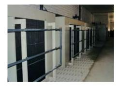
**Le laveur d'air biologique** pour batteries de ponte est pourvu d'un capteur supplémentaire de poussières. Avec une capacité de 2m³ par poule pondeuse, le laveur d'air biologique peut nettoyer 70% de l'air du poulailler.
