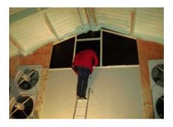
Laveur d'air biologique pour les porcheries. Construit par Dorset depuis 1994. celui-ci peut être réalisé avec ou sans aspiration centrale. La laveur d'air Biologique peut être réalisé sur mesure. Tant au milieu de la porcherie (canal d'air plus petit) que dans la paroi latérale ou en tête de bâtiment.
