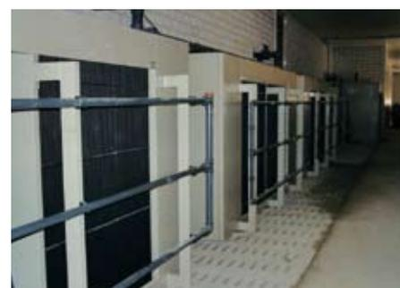
**Le laveur d'air biologique** pour batteries de ponte est pourvu d'un capteur supplémentaire de poussières. Avec une capacité de 2m<sup>3</sup> par poule pondeuse, le laveur d'air biologique peut nettoyer 70% de l'air du poulailler.
