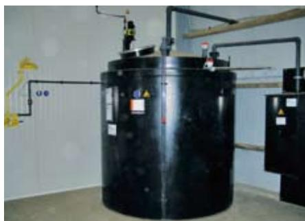
**Dans le cas d'un laveur chimique** trois niveaux, l'utilisation d'acide sulfurique est nécessaire. Cet acide peut être stocké dans une cuve statique (voir photo) ou dans des conteneurs échangeable d'environ 1000 litres.
